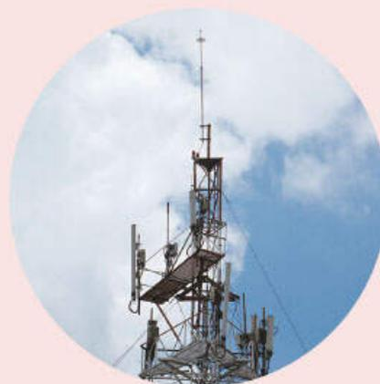
Un pararrayos es una estructura metálica que termina en punta. Su función es redirigir un rayo hacia la tierra, para disipar su energía y así evitar daños a personas o construcciones.
